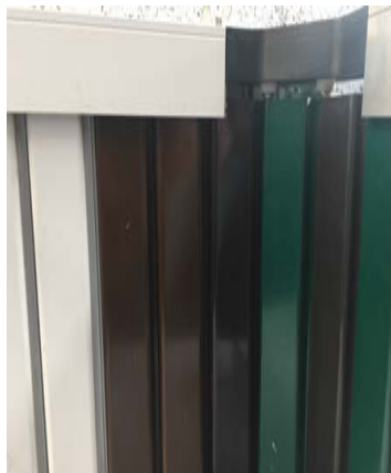
Umlenkung der Lamellen in den Ecken. Rechts oder Links möglich
