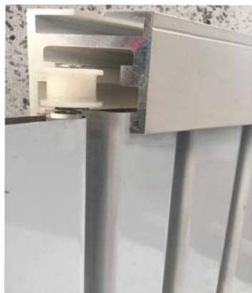
Halterung der Einzellamelle in der Führungsschiene
